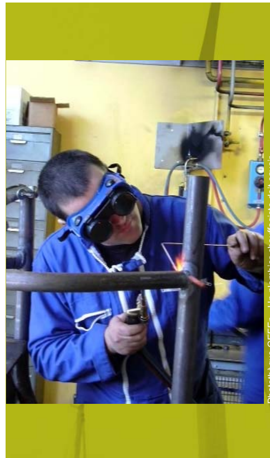
Photothèque GEFEn - Un plombier-chauffagiste doit savoir réaliser des travaux de soudure
