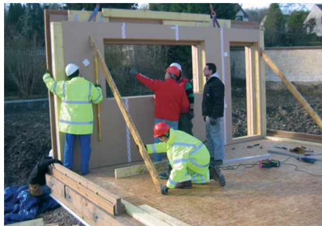
Construction d'une maison en bois par l'entreprise ERE Services dans le Val d'Oise.
