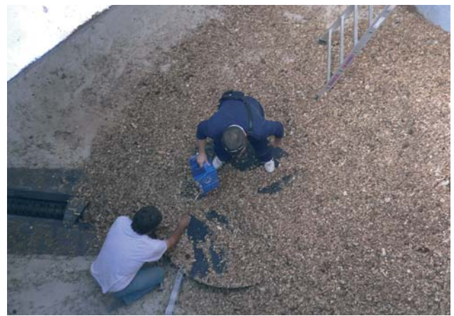
Alimentation de chaufferie automatique en bois d'Ile-de-France par Bois&Diversités.
